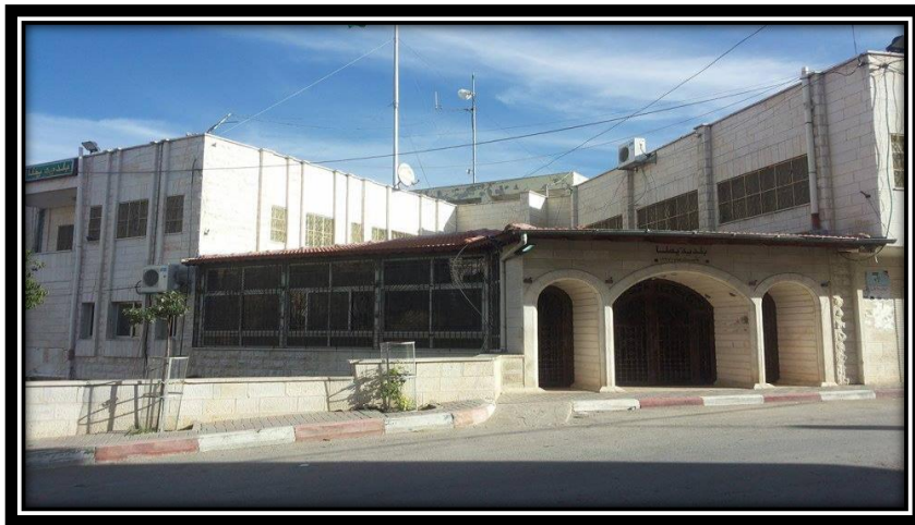
صورة (5-11): الواجهة التي تحتوي المدخل الحالي الرئيس لمبنى البلدي
