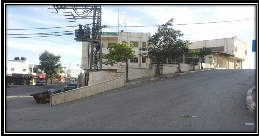
صورة (5-17): الواجهة الشمالية الغربية
