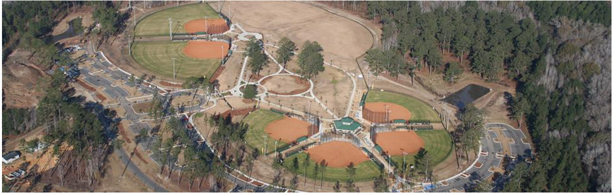
الشكل ( 12.5 ) : لقطه منظورية لحديقة البلوطات الثمانية وهي قيد الانشاء
