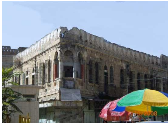
صورة ٢. 8: مبنى بلدية الخليل القديم (المصدر: الانترنت)
