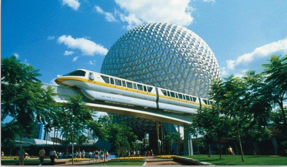
الشكل (١٦,٢): القطار الكهربائي في ديزني.
