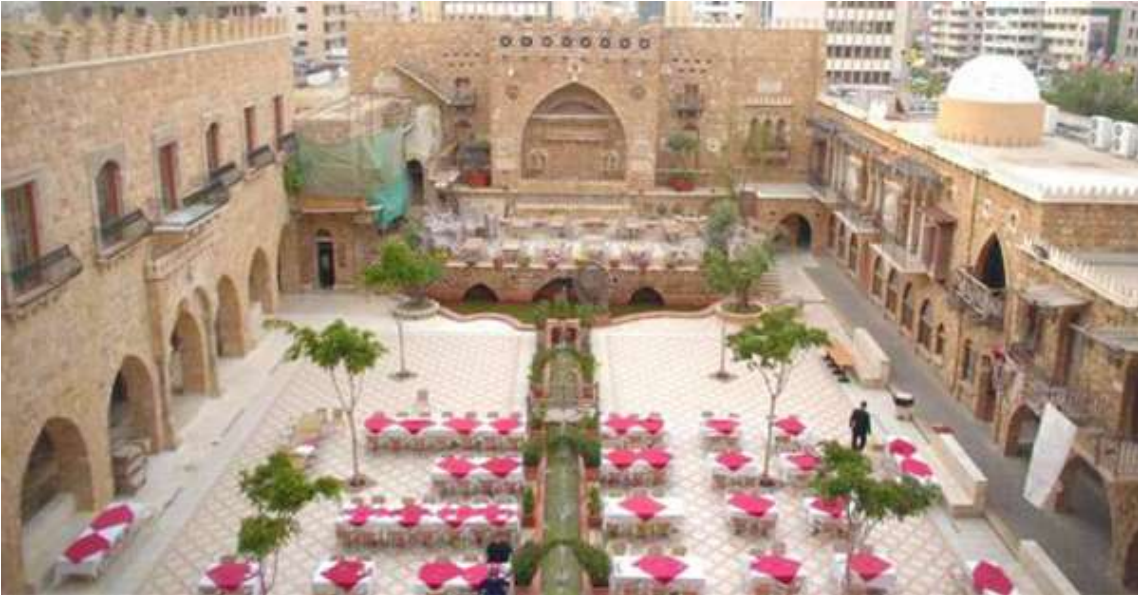
شكل ٢٨/٥ مجموعة صور لمطعم قرية الساحة التراثية في برج البراجنة بلبنان / المصدر مجلة عالم البناء عدد ١٧٨/٢٠٠٥م
