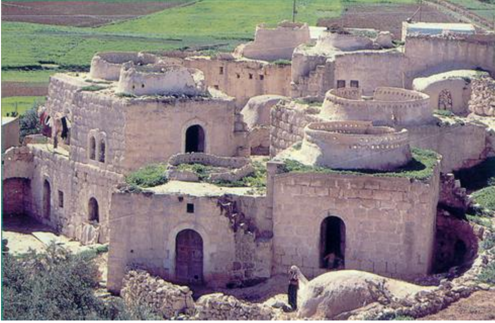
صورة ٢ / ٧ أحد أحواش قرية دير سامت عام ١٩٧٥م - المصدر كتاب العمارة الفلسطينية
