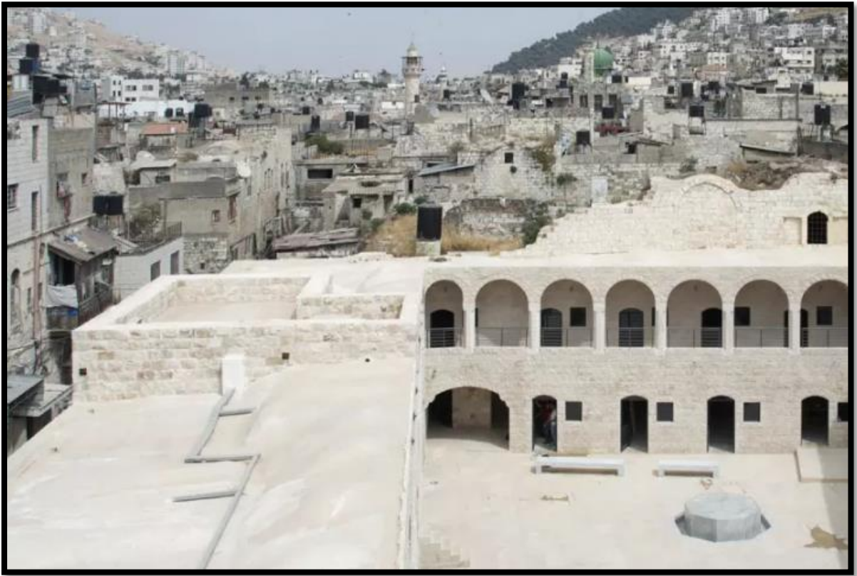
الشكل (7.5): يوضح مبنى خان الوكالة بعد إعادة ترميمه، المصدر: www.newlandscape.org
