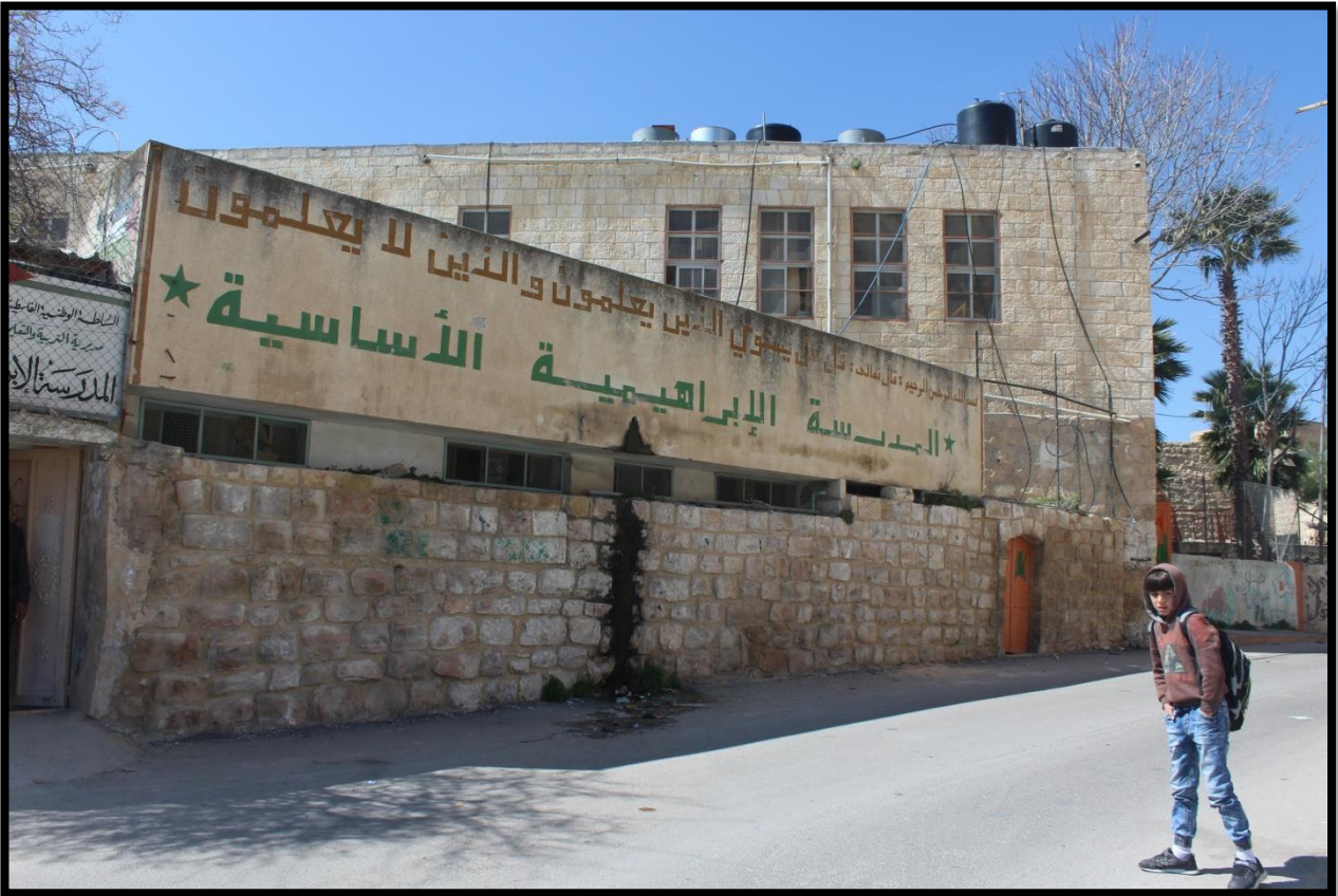
الشكل (13.6) يوضح مدخل المدرسة الإبراهيمية، المصدر: الباحثة.
