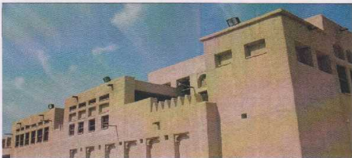
الشكل 24.4 مبنى قرية التراث
