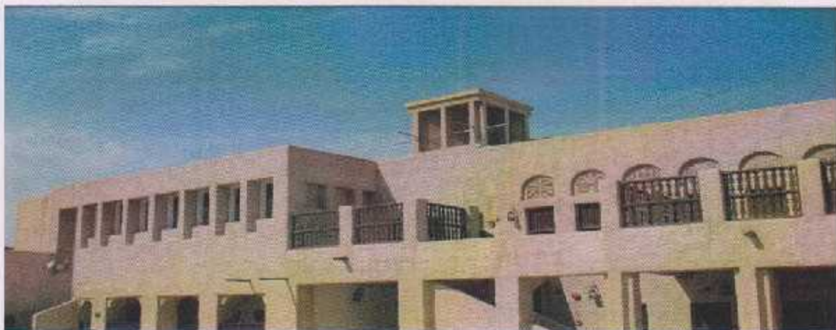
الشكل 23.4 مبنى قرية التراث
