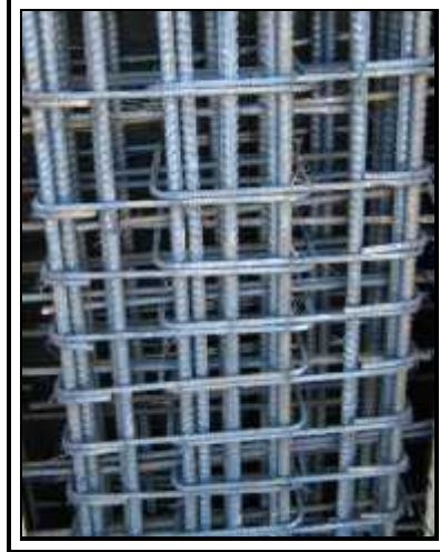
الصورة (٣-٣) تسليح عمودي مستطيل المقطع.
