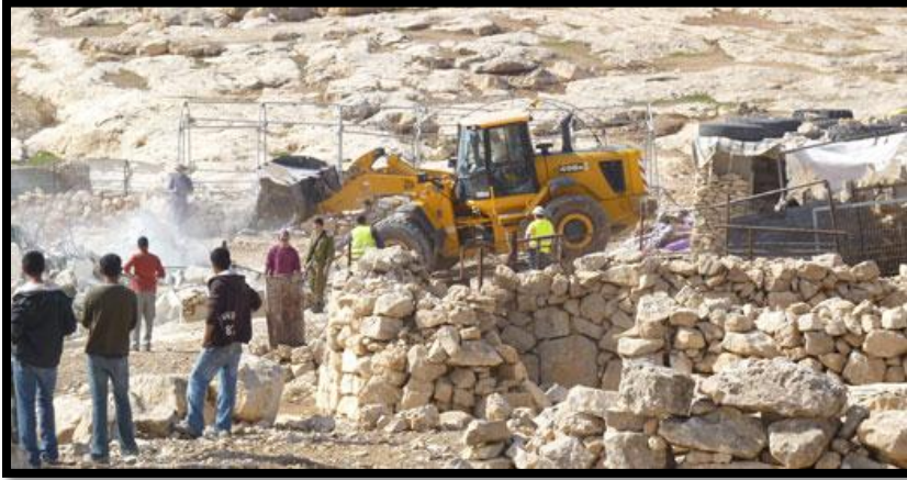
الصورة (6) : هدم منزل في قرية المقفرة، جنوبي الخليل. 2011/11/24. تصوير: نصر النواجعة، بتسليم
